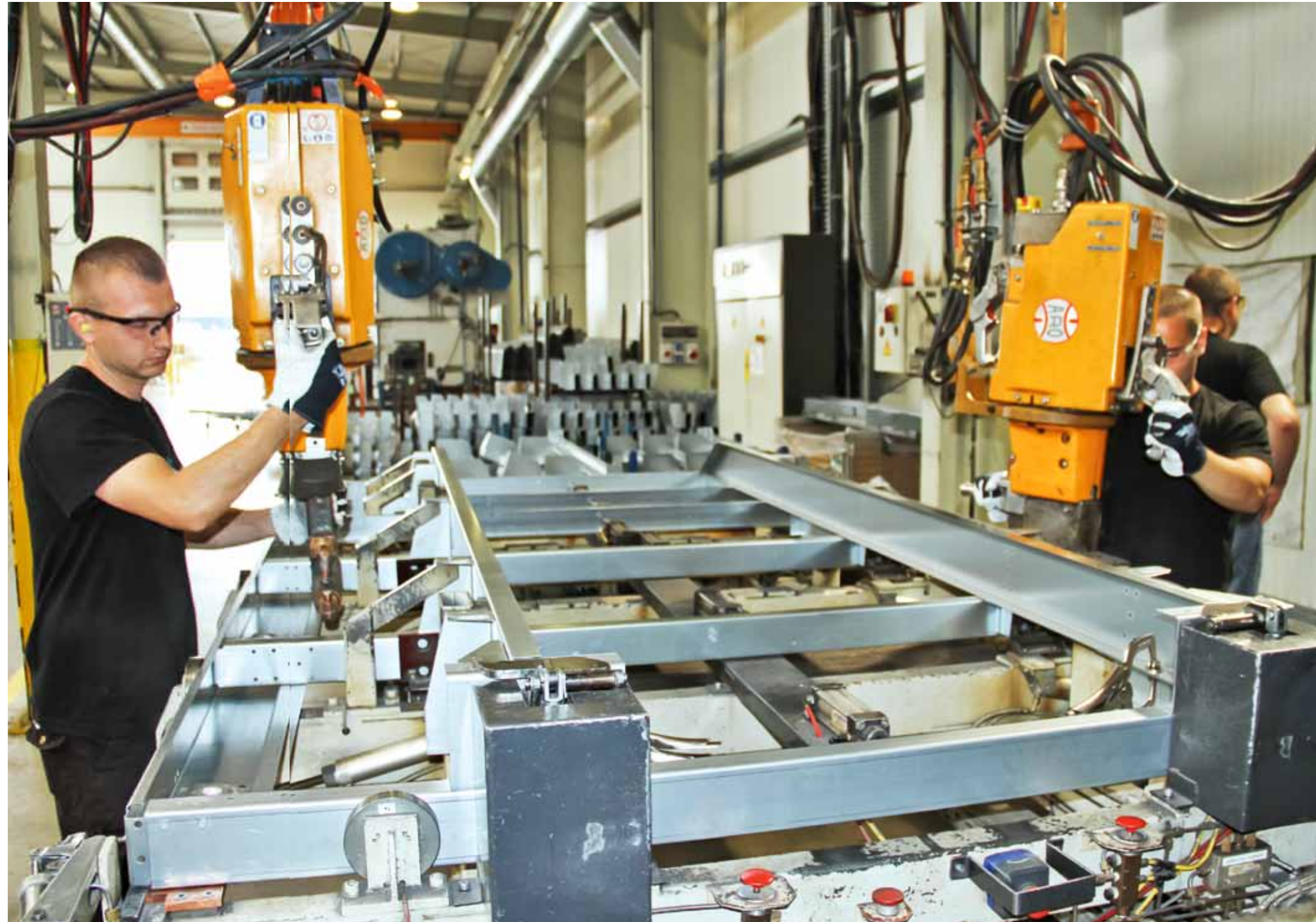
Rahmenbau mit hochmodernen Punktschweißautomaten. Alle Teile werden dazu millimetergenau auf dem Montagetisch fixiert.
