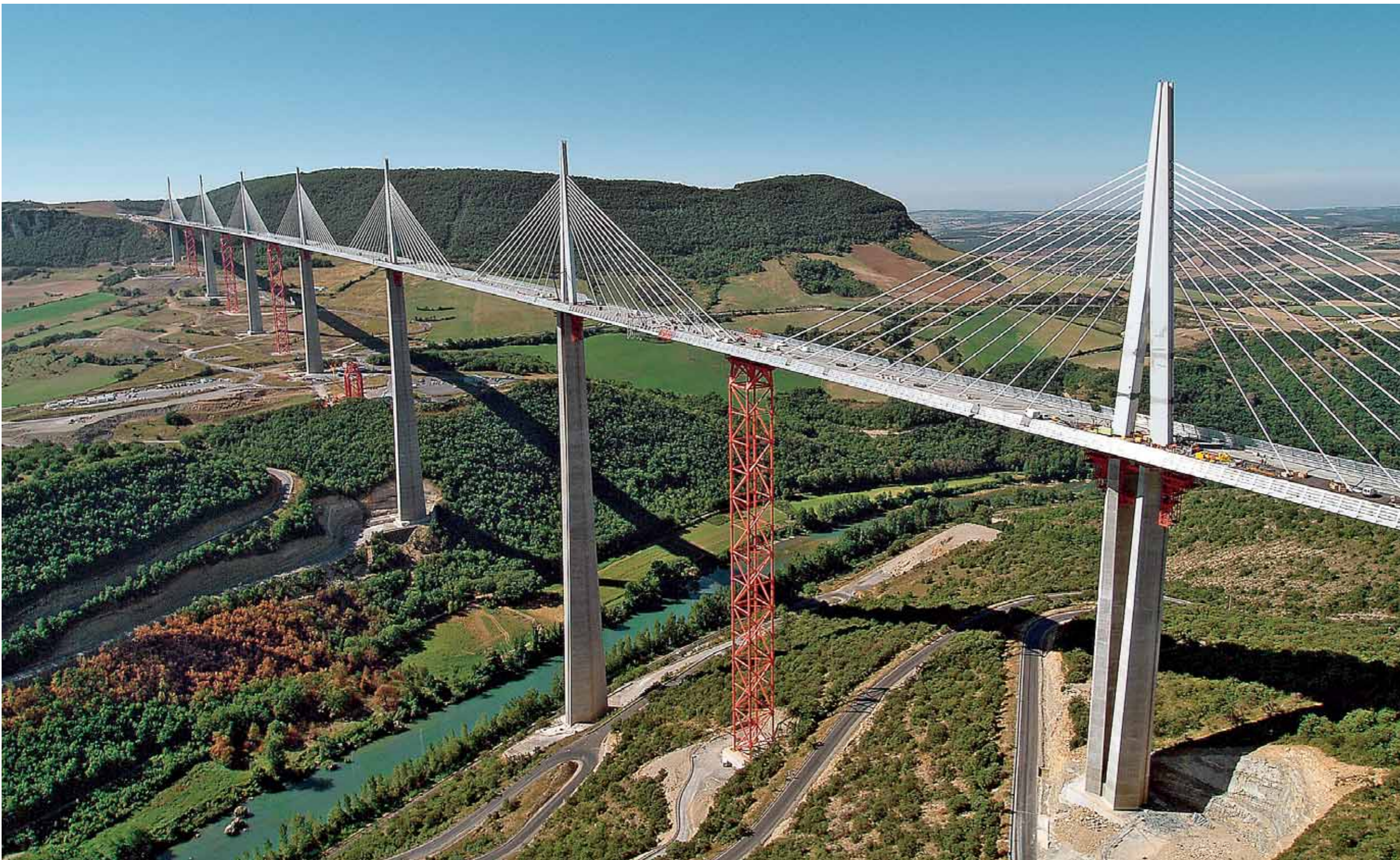
Das Brückendeck hängt während des Verschubs trotz der temporär unterstützend eingesetzten Zwischenstützen merklich durch. Erst mit dem Einbau der Schrägseile wird die Konstruktion ausgesteift
