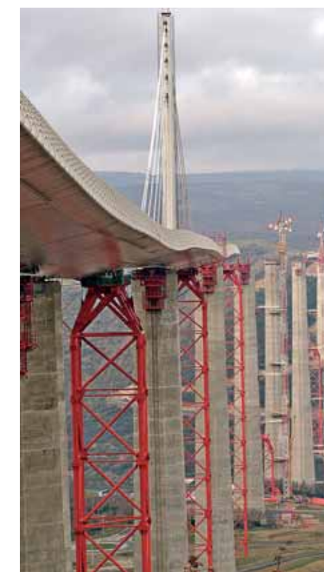
Das Brückendeck hängt während des Verschubs trotz der temporär unterstützend eingesetzten Zwischenstützen merklich durch. Erst mit dem Einbau der Schrägseile wird die Konstruktion ausgesteift
