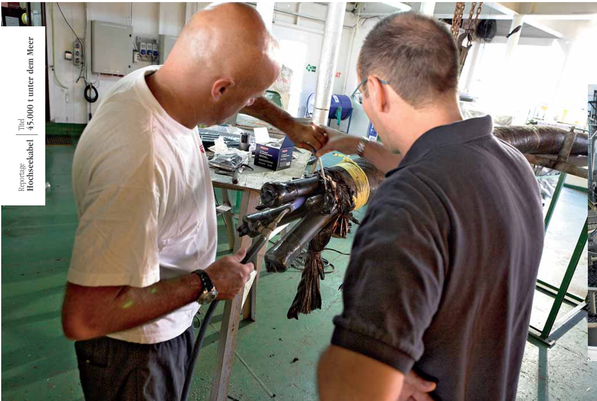
Anschluss auf hoher See: Die insgesamt fünf notwendigen Verbindungen zwischen den Teilstücken des Kabels müssen auf dem Schiff erstellt werden. Einmal schlich sich bei dieser Prozedur ein Fehler ein, der später zu einem vorübergehenden Ausfall der Leitung führte
