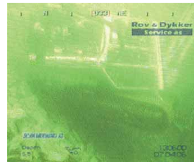
„Baggern Unterwasser“ mit Hilfe von ferngesteuerten Unterwasserfahrzeugen. Die herkömmliche Schaufel wird hier ersetzt durch einen leistungsstarken Saugrüssel. So wurde ein drei bis fünf Meter tiefer Graben für das Kabel erstellt
